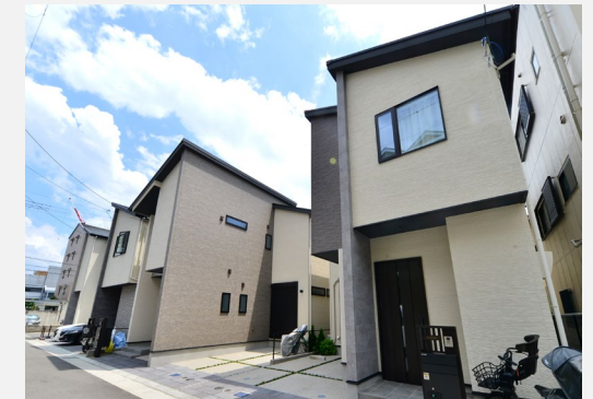
尼崎武庫之荘東PRIMES (兵庫県尼崎市)
