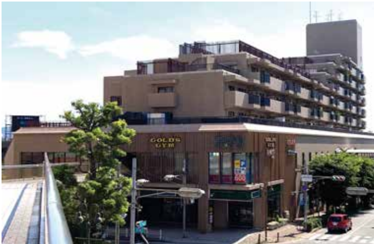
1986年、逆瀬川駅前再開発によって建てられたアピア3。
